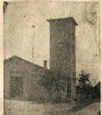
Gasilski dom PGD ŽELEZNIČAR v Bršljunu
