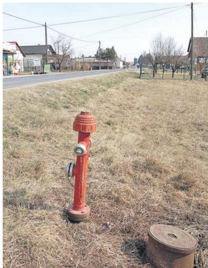
Vodovod je največja težava, saj jim v vodnjakih neprestano primanjkuje vode. Zdaj jim je žal, ker se pred 15 leti niso priključili na glavni vodovodni vod, ki se konča prav tukaj pri tem gasilskem hidrantu, ki je eden od štirih v vaseh. Tako pa morajo zdaj počakati na nov glavni vod in gradnjo sekundarnega vodovoda v okviru pomurskega vodovoda.
