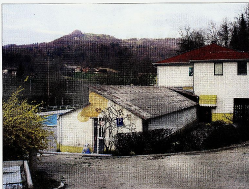
Obstoječi gostinski objekt pri bazenu bodo porušili in zgradili novega.
