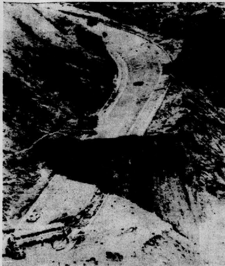
UDORI NA GLAVNI CESTAH — Usodnemu tropskemu deževju, povodnjim in človeškim žrtvam je v Braziliji sledilo tole: zemeljski udori so na mnogih krajih pretrgali promet tako kot na glavni avtocesti med Rio de Janeirom in Sao Paolom. Telefoto: UPI
