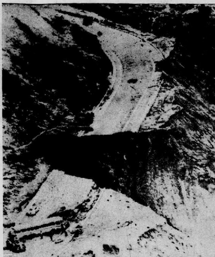
UDORI NA ŽELJEZNIČNI PROMET — Usodnemu tropskemu deževju, povodnjim in človeškim žrtvam je v Braziliji sledilo tole: zemeljski udori so na mnogih krajih pretrgali promet tako kot na glavni avtocesti med Rio de Janeirom in Sao Paolom. Telefoto: UPI
