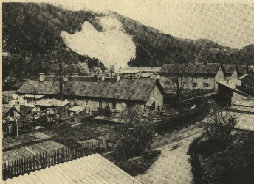
Del rudniškega stanovanjskega naselja. Nasipi (III. in IV. etaža) v Trbovljah (foto: B. Klančar)
