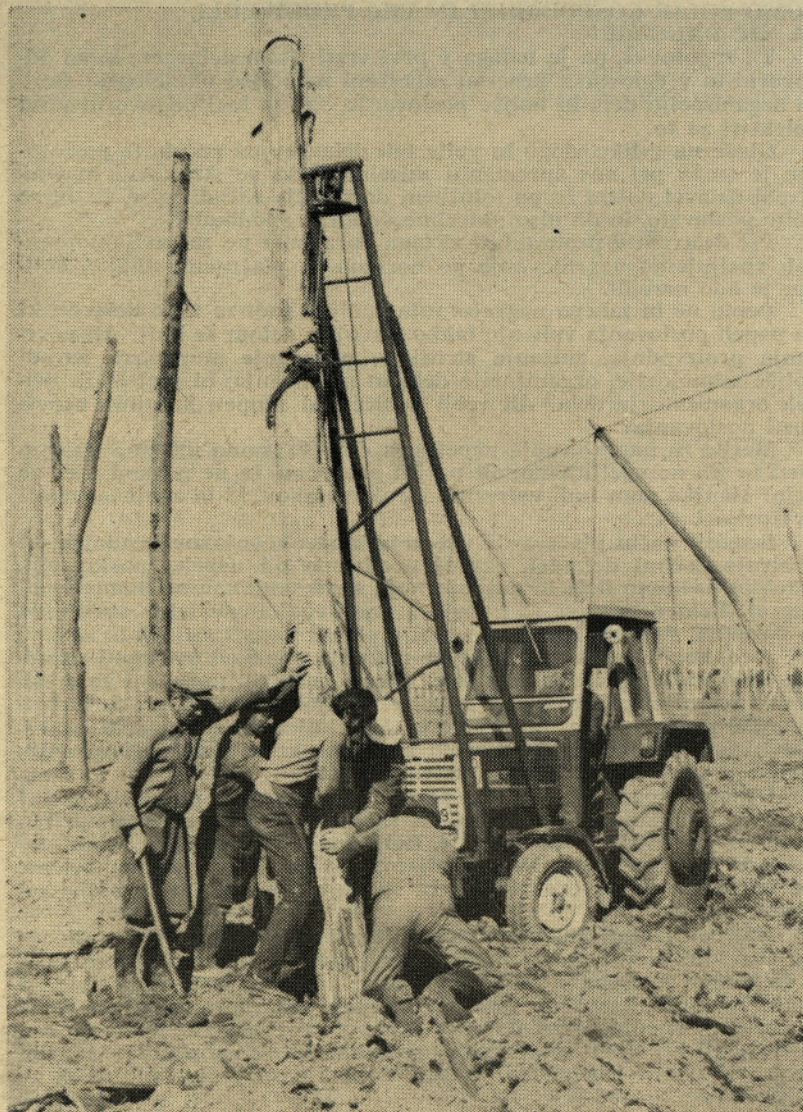
Iz stare vitle in z malo domišljije so v Arji vasi skonstruirali dvigalo za dviganje drogov. S tem so zelo olajšali in pospešili gradnjo žičnic.
