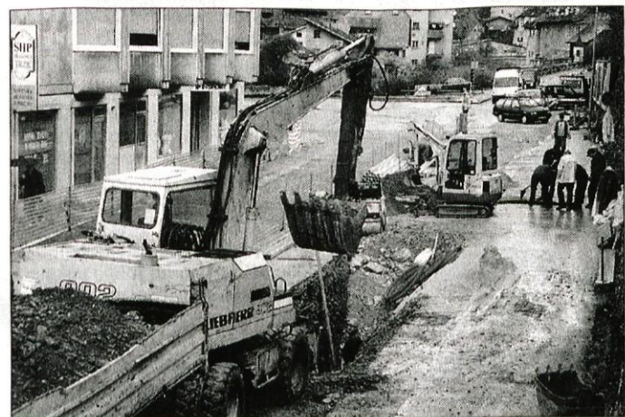
Na sliki: gradbišče ob tržiški stolpnici.
