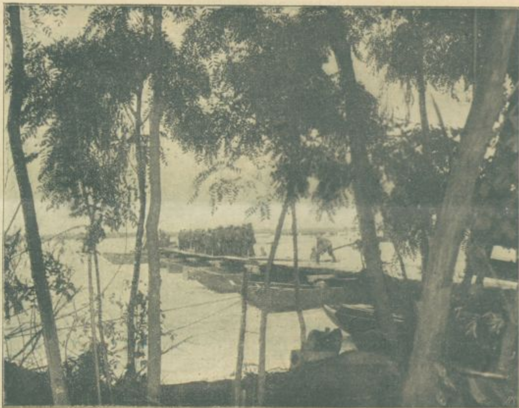
Na hregu narastle Piave: Naše vo tvo popravlja po povodnji razdrt pontonski most.
