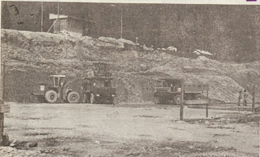
Pri zemeljskih delih za novo valjarno na Jesenicah smo uporabljali najmodernejšo mehanizacijo
