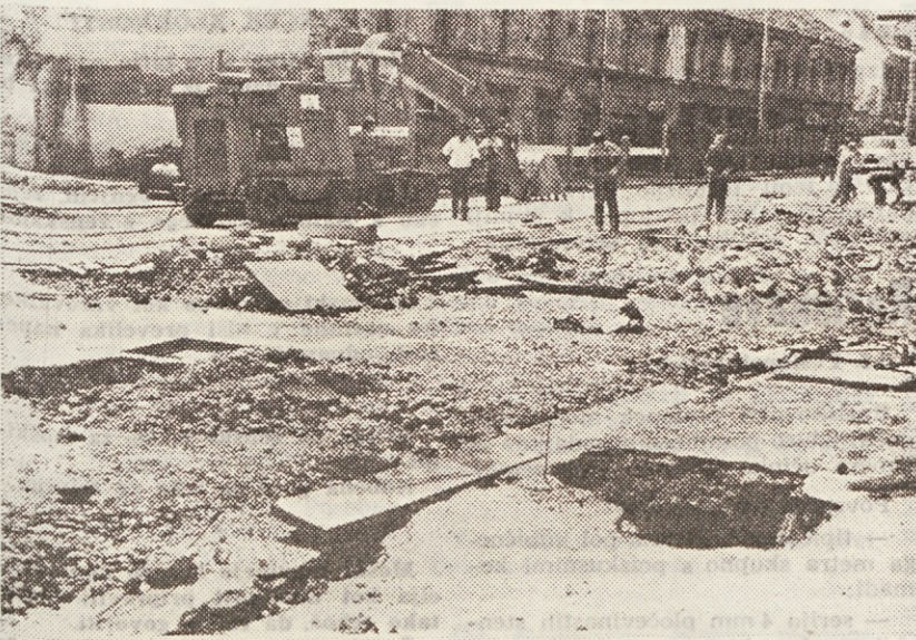
Tik pod asfaltno prevleko so stare tramvajske tračnice, ki jih bodo sedaj dokončno odstranili
