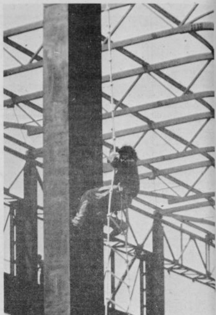
Antikorozijska zaščitna dela na termoelektrarni Reka.
