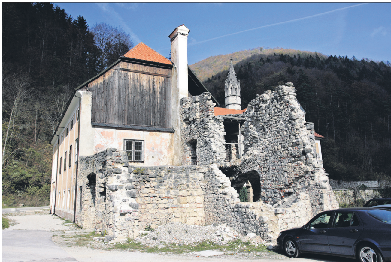
V Jurkloštru težko čakajo na gradbena dela, ki bodo Pristavo predelala v primerno prizorišče za kulturno dejavnost.
