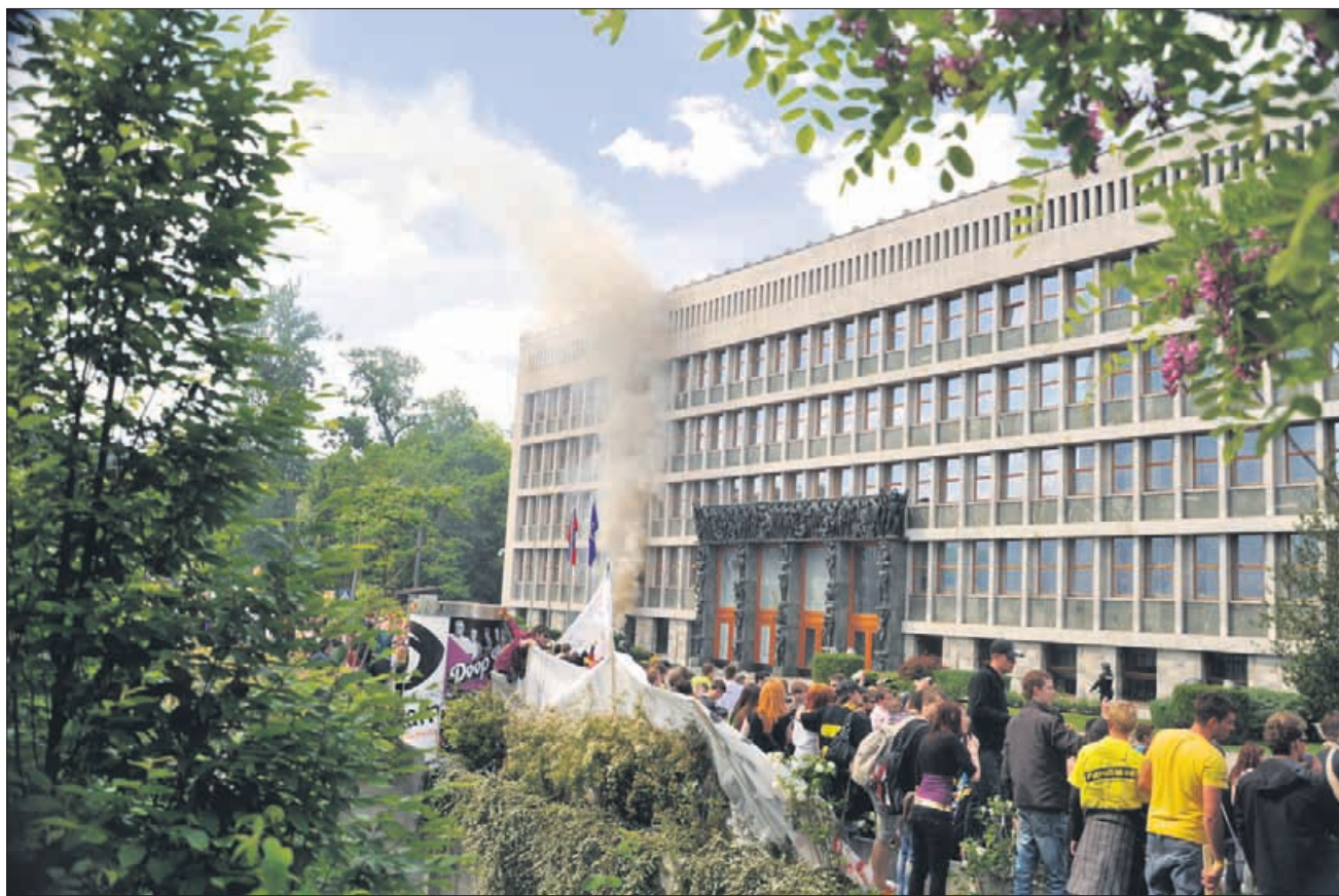
Razbita okna, poškodovano pročelje in požgano grmičevje – skupaj za slabih 30 tisočakov škode. Državni zbor bo za povračilo dela škode tožil organizatorje demonstracij.
