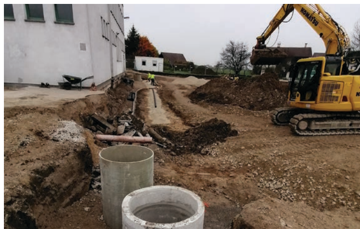
Prestavljanje komunalnih vodov
