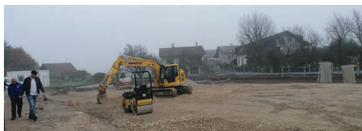
Zasip z utrjevanjem terena
