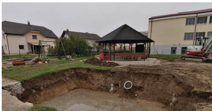
Prestavljena uta in izkop za zunanje sanitarije
