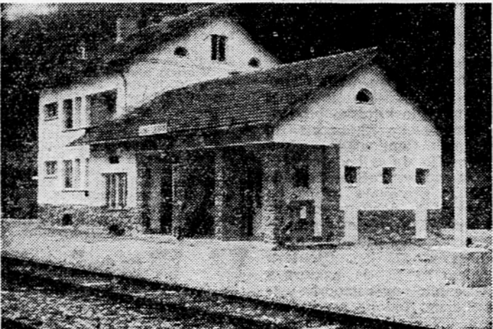
Nova železniška postaja Vuhred — Elektrarna
