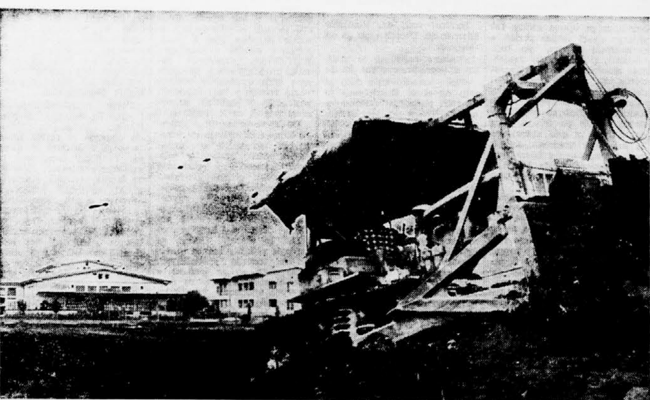
NOVO POSLOPJE TUBE — Te dni so začeli za Bežigradom ob Tolstojevi ulici poleg ljubljanskih mlekar graditi novo tovarniško zgradbo. Za podjetje Tuba, ki je sedaj utesnjeno v premajhnih prostorih v Kamniški ulici in zaradi tega ne more razširiti proizvodnje, gradi novo halo gradbeno podjetje »Tehnika«.
