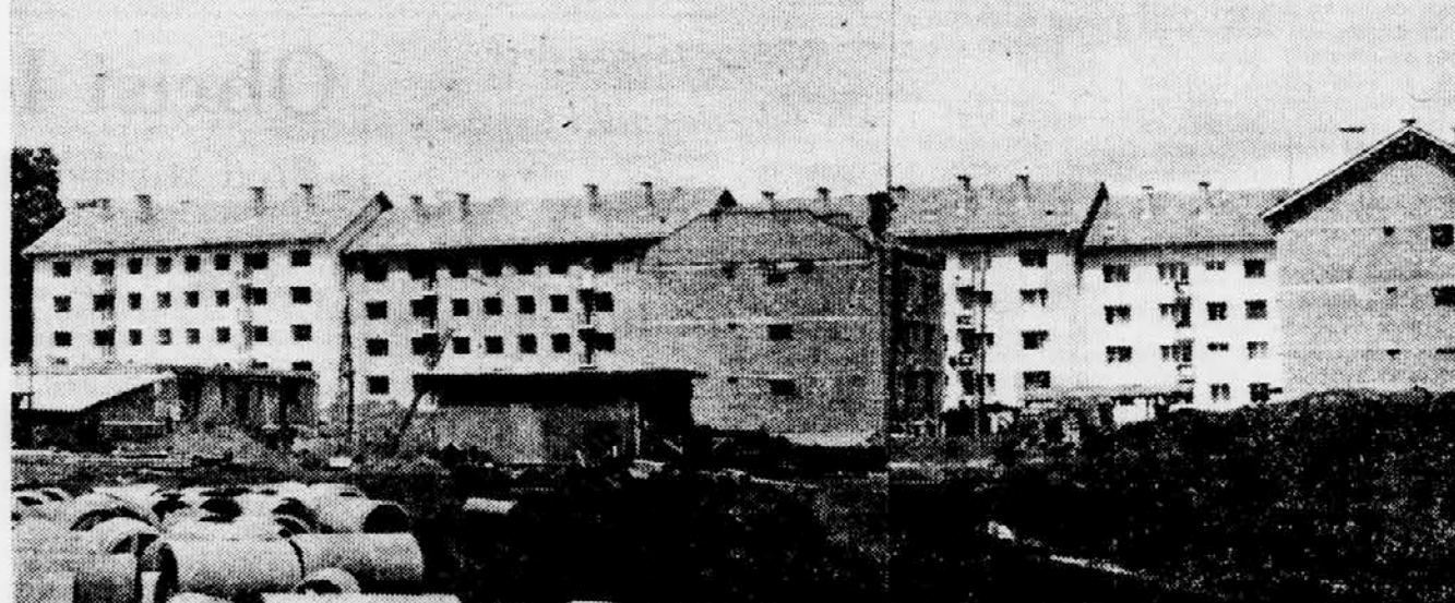
NOVI STANOVANJSKI BLOKI V PTUJU — Gradbišče pri Ljudskem vrtu
