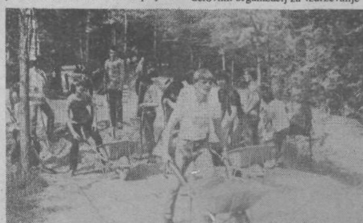
Enodnevne akcije srednješolske mladine so sestavni deli gradnje PST (Fotoarhiv odbora za izgradnjo PST)
