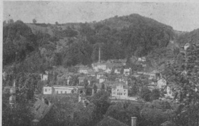
Pogled na severozahodni del Laškega v ozadju Tekstilna tovarna
