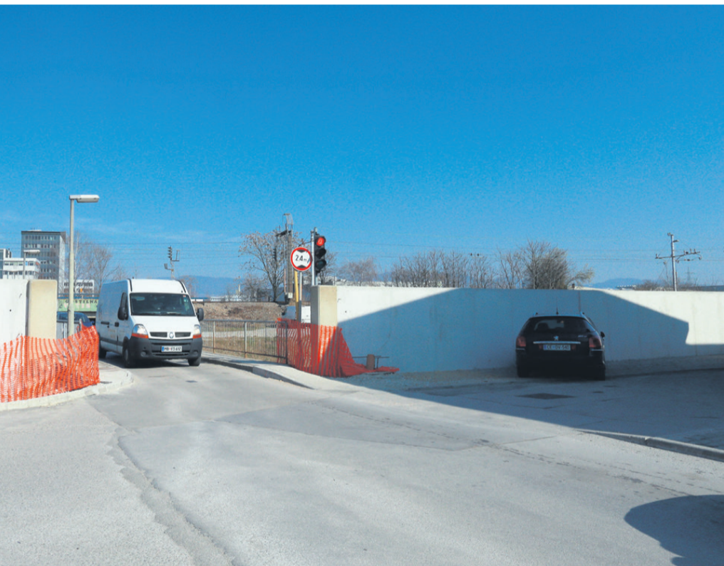
Stavbe zaščitila pred naraslimi vodami. Na tem delu je predvidena še namestitev mobilnih zagatnic, kot je to Polul.
