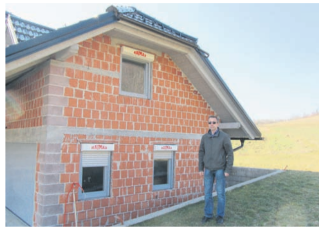
Nova hiša Škobernetovih stoji nekaj metrov pod plazom. Čeprav na hiši zaenkrat še niso vidne posledice plaz, škarpa že poka, pravi Jernej.
