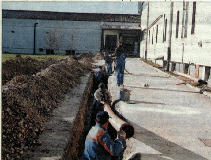
Med gradnjo kanalizacijskega voda na Polzeli
