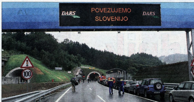
Z novozgrajenim avtocestnim odsekom pri Trojanah bo Slovenija dokončno povezana - med Mariborom in Koprom ne bo več ovir.
