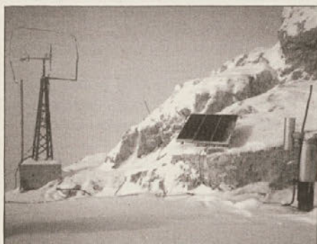
Sončne celice predstavljajo rešitev tam, kjer so potrebe po električni energiji, ni pa električne napeljave.
