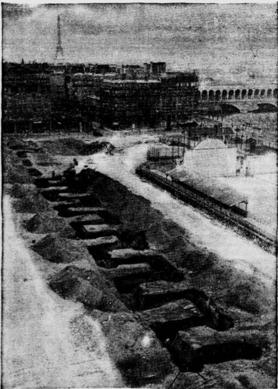
V Parizu so začeli graditi na Boulevardu Murat betonska zaklonišča, v katerih bo prostora za 80 tisoč ljudi. Na sliki prikazuje nove izkope v bližini Auteuilskega vialukta
