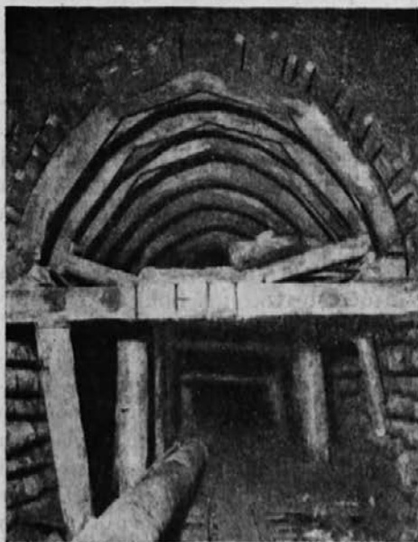
Predor Ivan med gradnjo.
