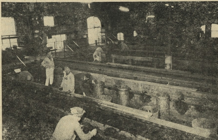
Posnetek iz dela pri odbiranju premoga oziroma jalovine na stari separaciji premoga v Trbovljah pred tremi desetletji
