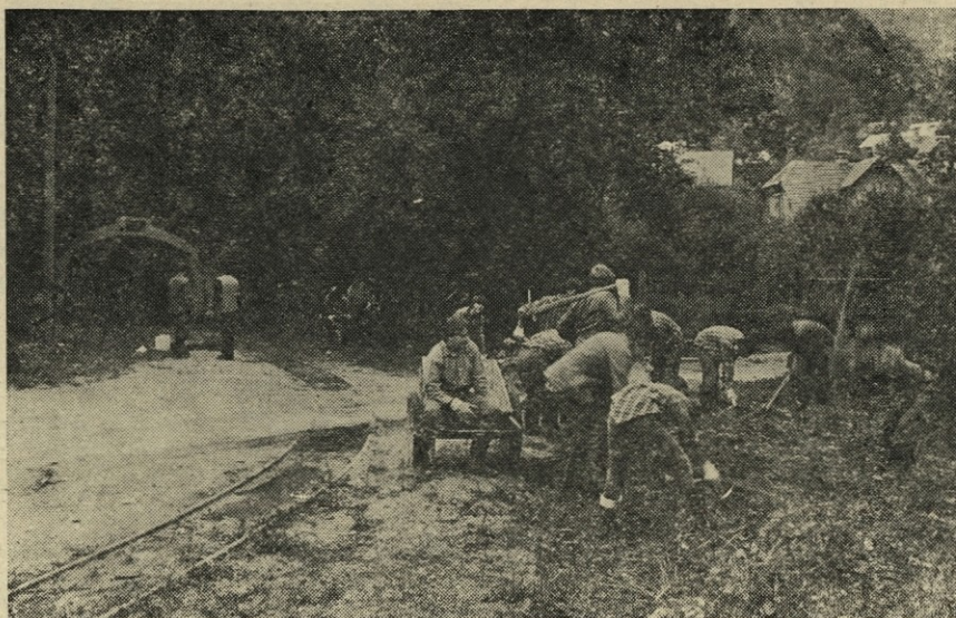
V septembru t.l. so bili učenci Rudarskega šolskega centra angažirani tudi pri obnavljanju objektov in okolice bivšega obrata Dol, kjer bodo imeli v bodoče svoje šolsko delovišče.
