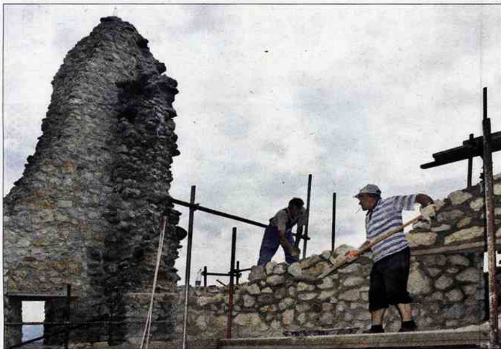
Delavci podjetja Gradia so pred dnevi začeli z obnovo gradu in bodo na Žovneku ostali najkasneje do jeseni.
