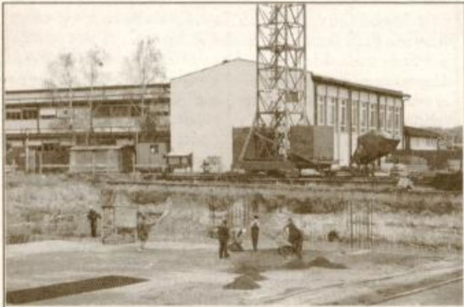
Prejšnji teden so delavci Gradisa na gradbišču pri OŠ Gorišnica delali temelje za nov objekt
