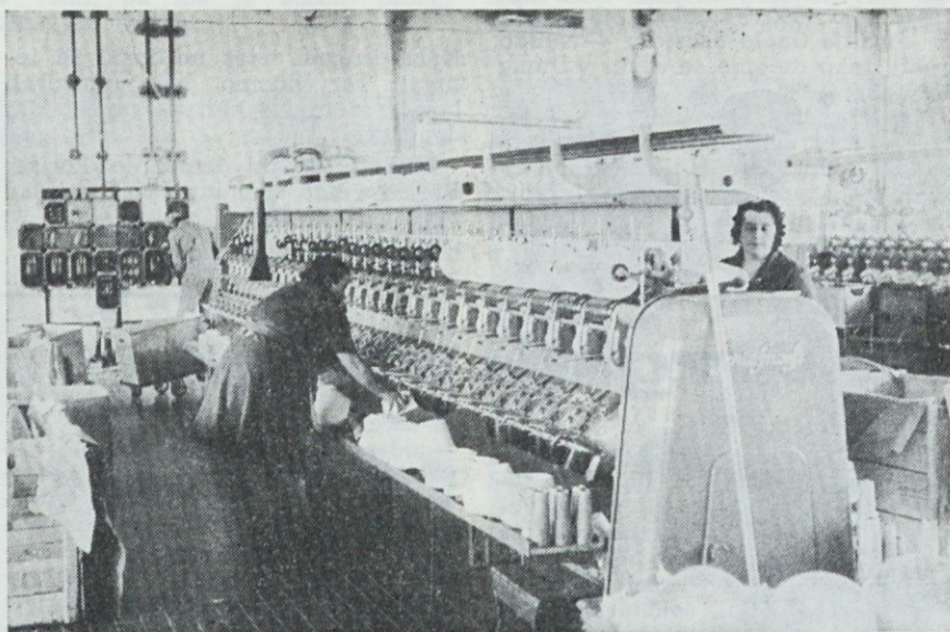
Pri delu z novim križno previjalnim strojem
