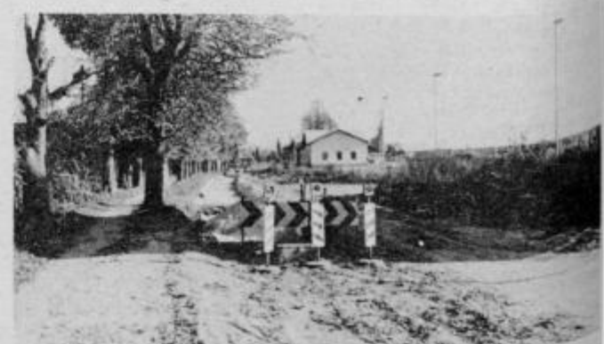
Dela na cesti ne bodo ravno majhna in tudi poceni ne, saj je potrebno urediti kanalizacijo, pločnike in osvetlitev.
