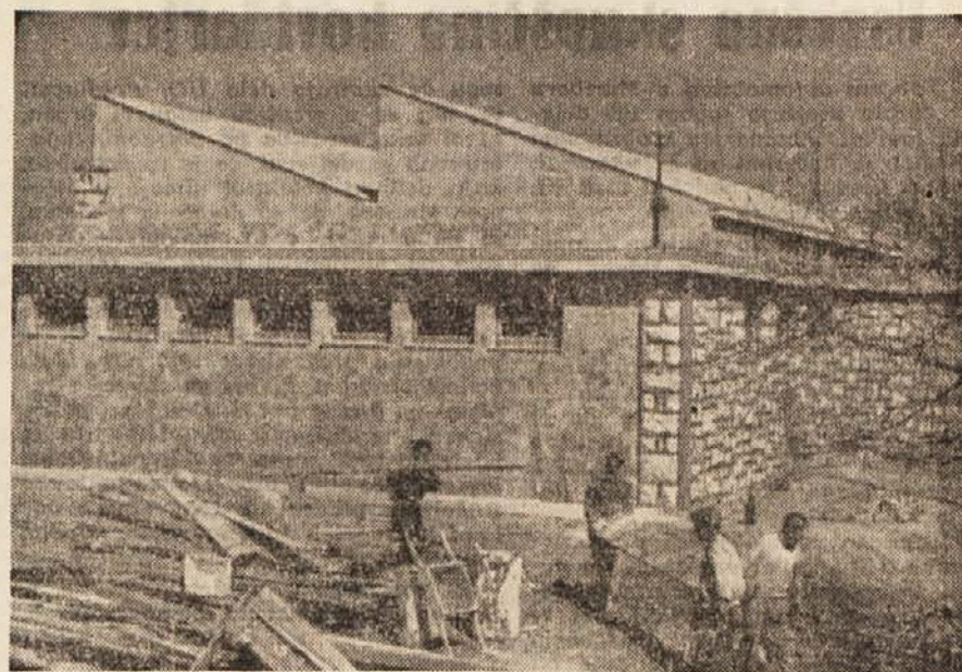
Pletilnica v Novem gradu je že zgrajena
