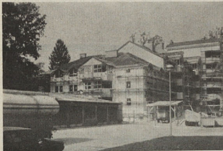
To pa je gradbišče v Frankovem naselju v Škofji Loki.
