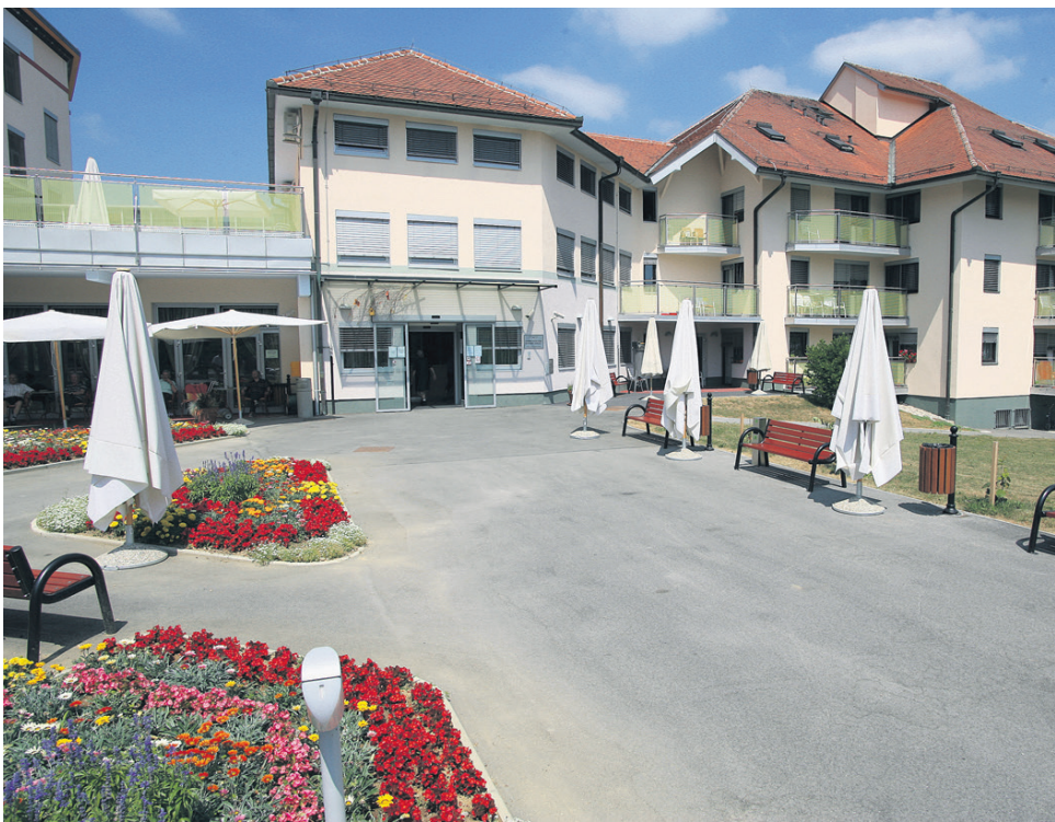
Gradnjo in obnovo Lambrechtovega doma preiskujejo kriminalisti.
