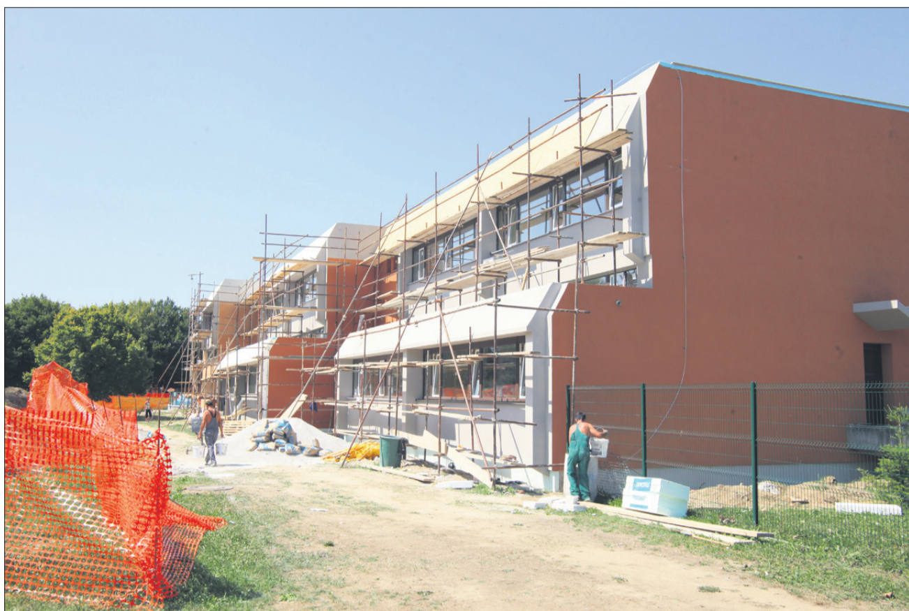
II. OŠ Celje bo učence septembra pričakala z novim stavbnim pohištvom ter s toplotnim ovojem pod novo fasado.
