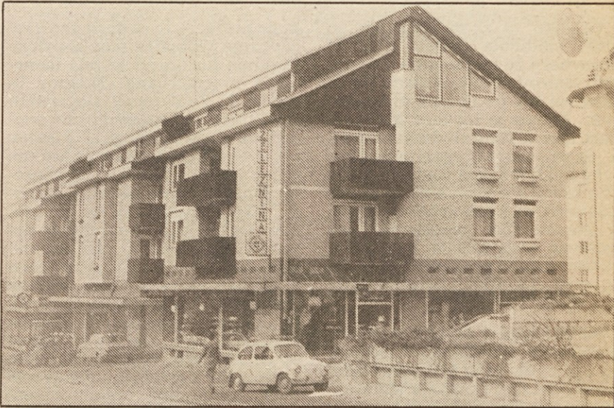
Poslovno stanovanjski blok, v katerem je tudi Železnina M-Zarje, so zgradili Ogradovi gradbinci. Vse foto: Jože Rozman
