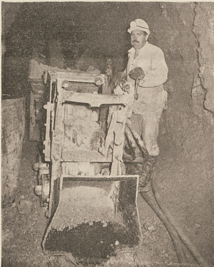
Obrat za specialna rudarska dela sodeluje pri rekonstrukciji cementarne v Trbovljah, z izdelavo rova za transport surovine iz Pleskega v cementarno
