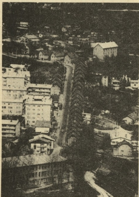
Stara rudarska kolonija Kurja vas in Fani, ob njej pa novi stanovanjski bloki ter individualne hiše. (Foto: B. Klančar)
