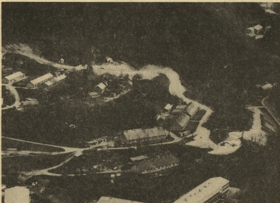
Del naselja Nasipi (tretja etaža) z novim Frančiška rovom — vhodom in novo industrijsko cesto, ki pelje iz Lakonce do priključka na glavno cesto pri Sušniku.
