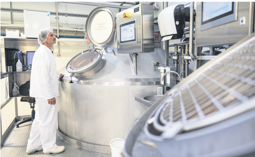
Mlekarna Celeia se je v prvem delu prenove sirarne lotila najbolj ključnega dela proizvodnje sirov. Zamenjala je sirarske kotle.
