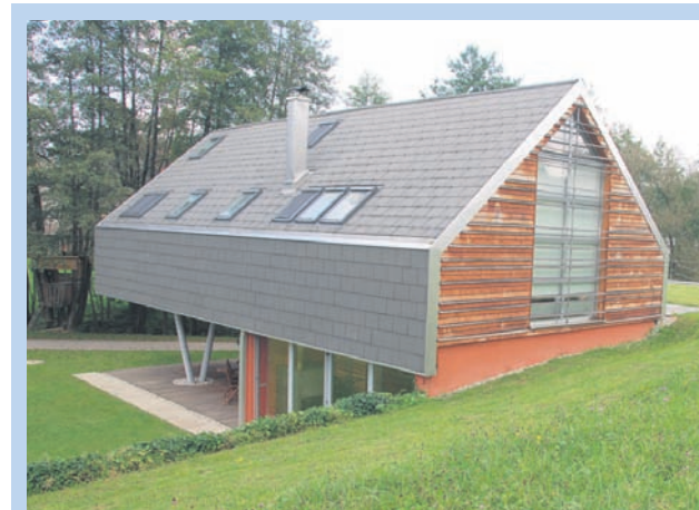
Hišo Trunklovih v Šentjurju sta zasnovala Damjana Zaviršek Hudnik in Robert Mašera. Sredi gradnje je bila videti tako nenavadno, da je tu in tam kdo vprašal, če gradijo raketo ali hišo.
