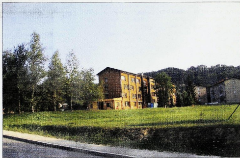
Z ureditvijo novega doma starejših občanov v Štoreh nameravajo začeti, če ne bo nepredvidenih zapletov, še to jesen. Stavbo »internata« bodo nadzidali ter zgradili velik prizidek.
