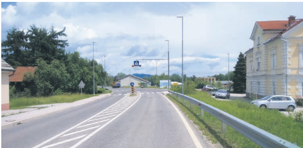
Zaradi del lahko vozniki na regionalni cesti v Latkovi vasi to poletje pričakujejo oviran promet in zastoje. A ko bo krožišče zgrajeno, bo pretočnost prometa boljša.
