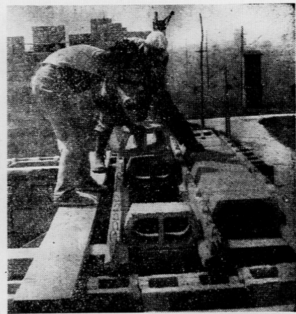
Montaža stropov je kaj preprosta. Najprej polože že izdelane armirane stropne nosilce, vmes vložijo polnilne elemente, nato pa zalijejo z betonom hkrati strop in notranjost nosilnih sten
