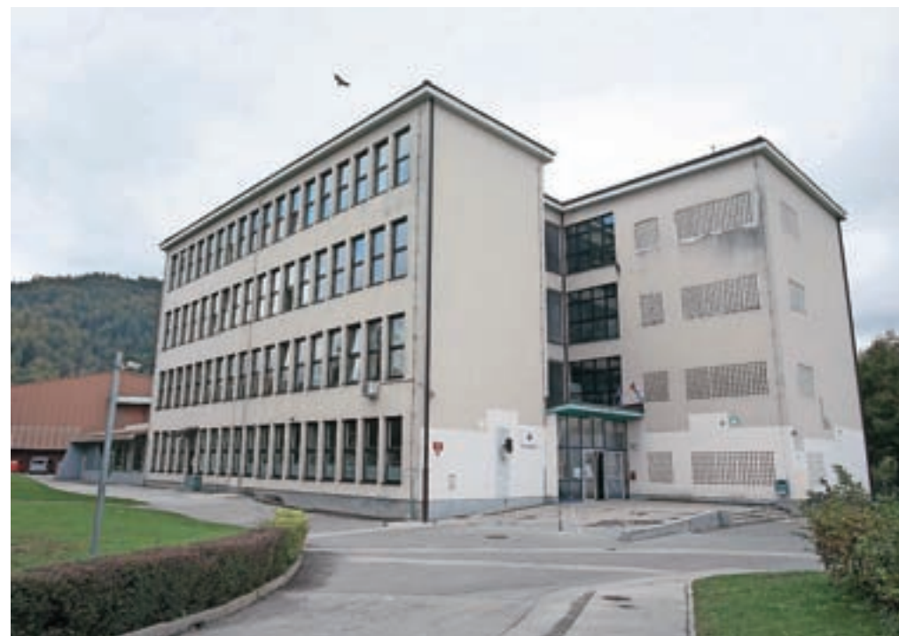
Staro šolo bodo po dokončanju nove porušili. / FOTO: GORAZD KAVČIČ
