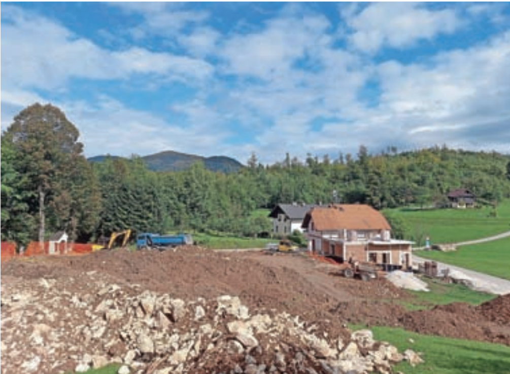
Prizidek h gasilskemu domu bo kmalu pod streho, še jeseni bo dokončano tudi igrišče.
