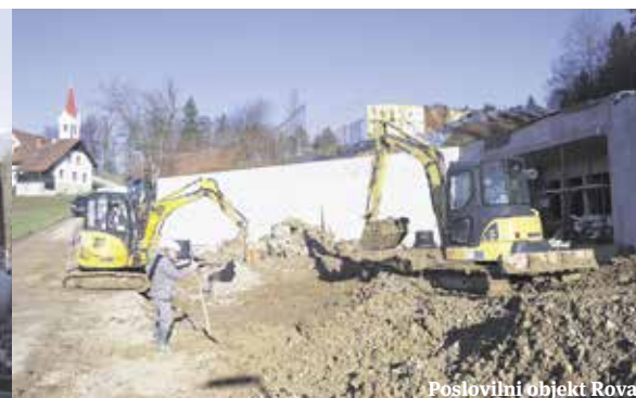
Poslovni objekt Rova
