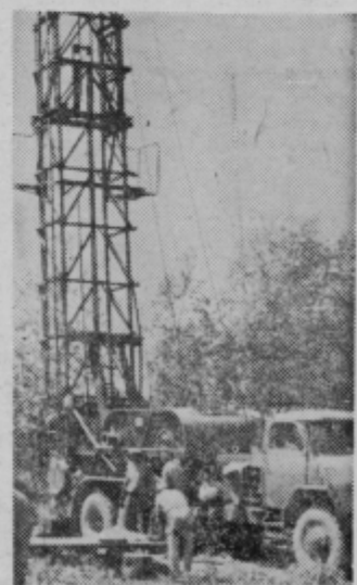
Visok žerjav spušča cevi v že skoraj 800 metrov globoko vrtino
