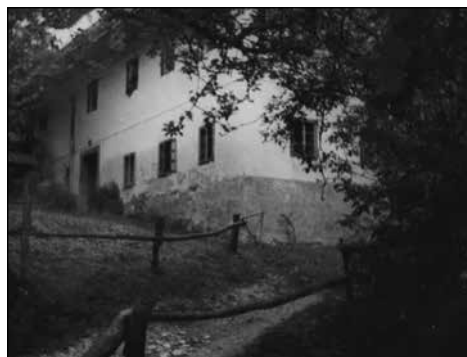
Pri Štalcu v Osojniku okoli leta 1960- ograjena pot (zgojne) za napajanje živine na koritu. Na levi strani fotografije je šterna in nad njo mala streha iz leta 1953. Foto: arhiv avtorja
