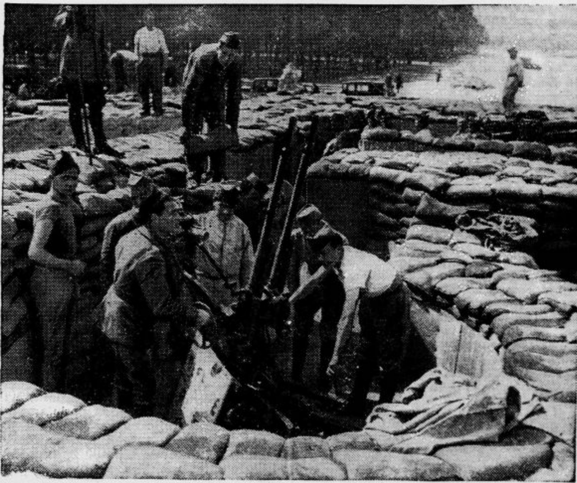
Na Trgu invalidov v Parizu so izkopali zaklonišče za strojnoco proti napadom iz zraka
