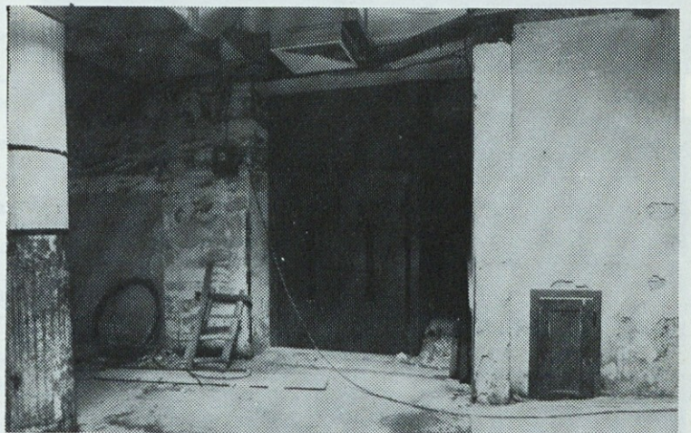
Montaža dvigala za transport pramena iz predpredilnice v oddelek brezvretenskih predilskih strojev
