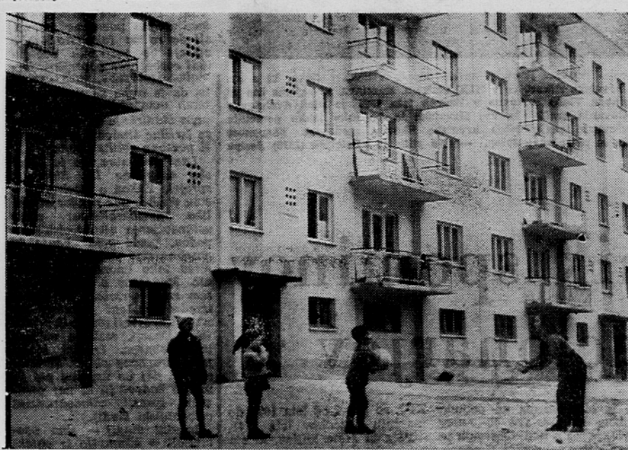
Pred kratkim so v Zagorju ob Savi dokončali tretji stanovanjski blok, v katerega se je vselilo 34 družin. Foto Z. Deniša
