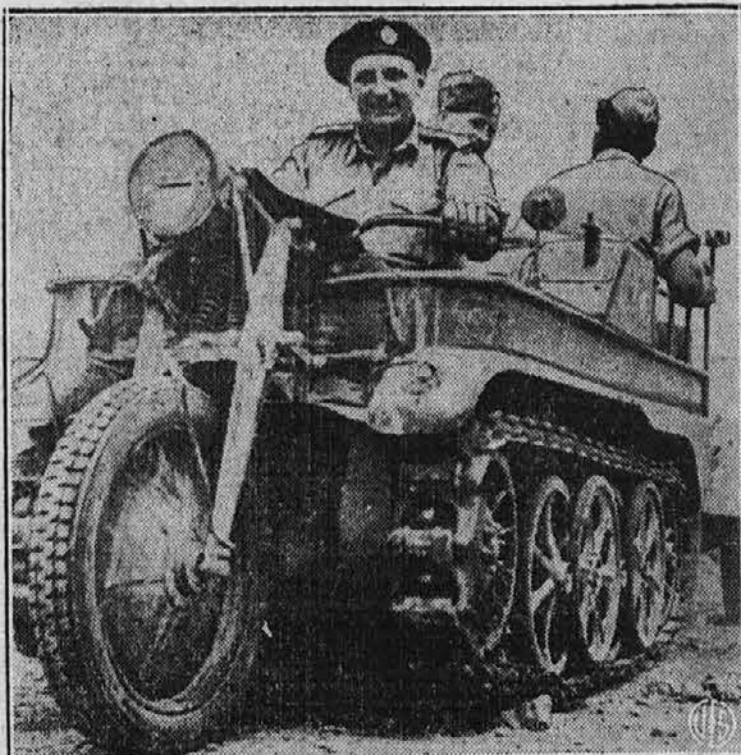
Nove vrste vojaško vozilo, kakršne uporabljajo čete osiše na libijskem bojišču, so nedavno zajele zavestniške čete. Kakor vidimo je to kombinacija motornega kolesa in traktorja. Vporabljajo taka vozila za prevažanje vojaštva in manjših topov.
