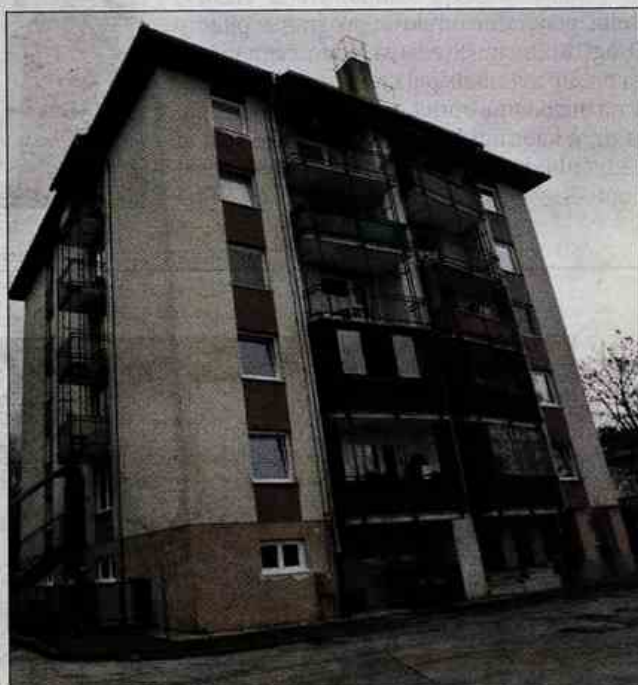
Stanovalci blokov v Keršovi ulici v Vojniku so zaradi težav s kanalizacijo praktično ostali brez kleti.
