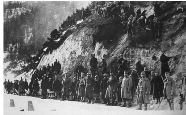
Ruski vojaki pri gradnji ceste na Vršču.
