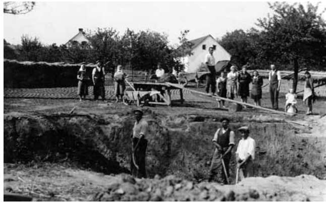
Izdelava in sušenje opeke za gradnjo hiše. Foto Julij Schönauer, Šalovci, leta 1943.
